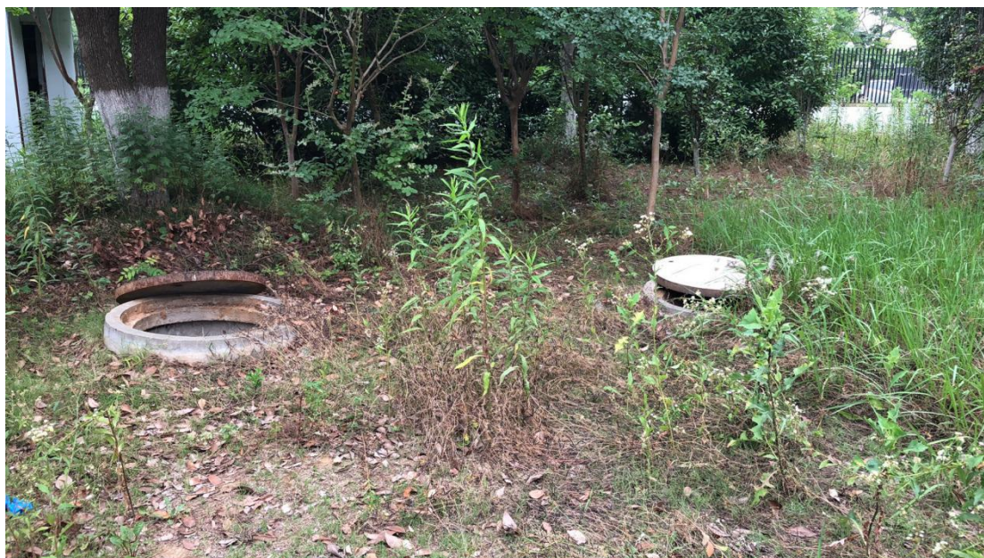
附件 7、处理设施照片（雨污排口、气瓶固定）
